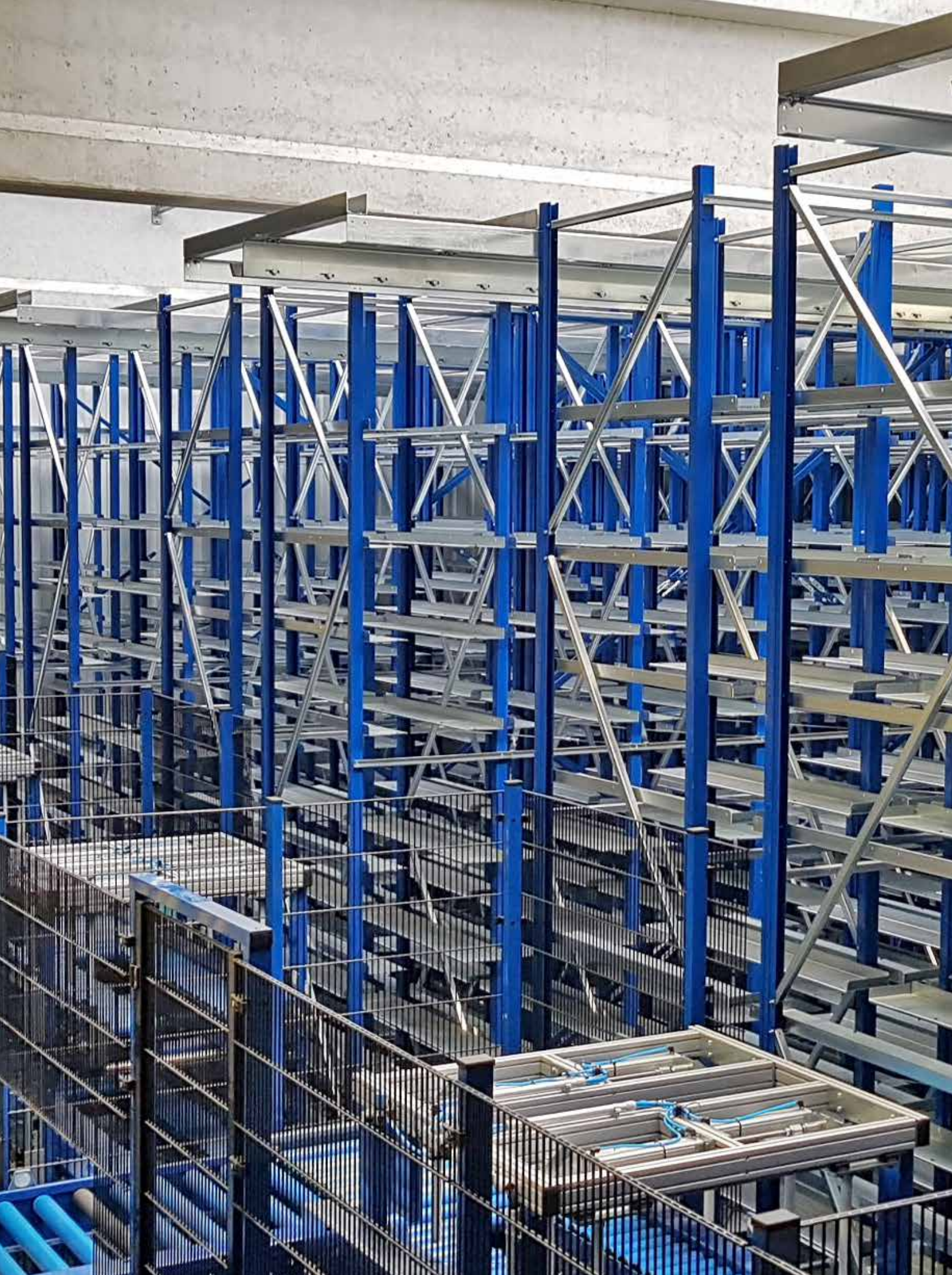
Mini load - Double deep | 13,250 box positions
